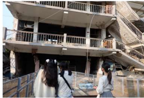
▲倒壊した建物を見学している様子
